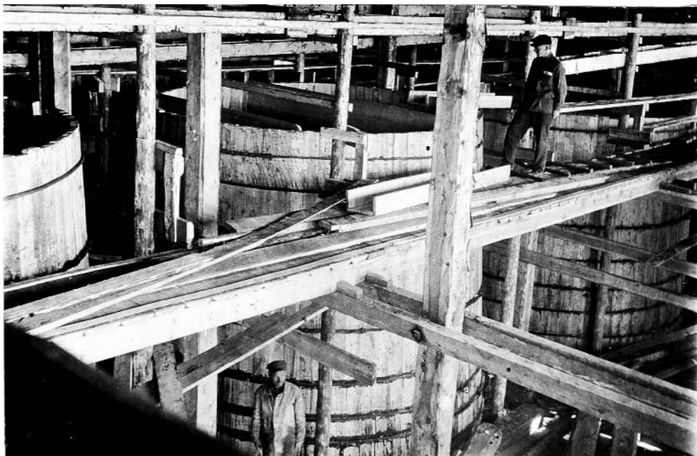
Строительство чанов на химзаводе № 1, 1931 г. (из архива И.В. Дахно)
